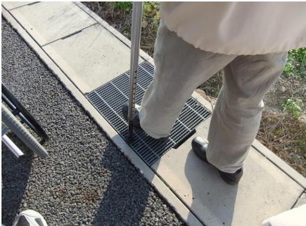
松葉杖も挟まらない 良いグレーチング
