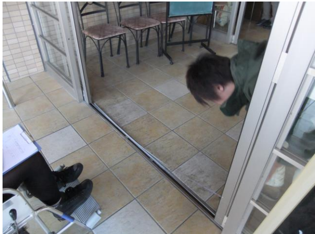
玄関の入口の広さは？開閉は？ 段差はないか？床表面は滑りにくい？
