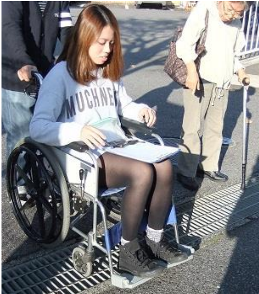
タイヤがはまって動けなくなってしまった 悪いグレーチング
